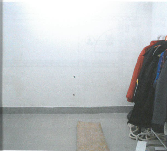
W - V m.č. 003 severní stěna
