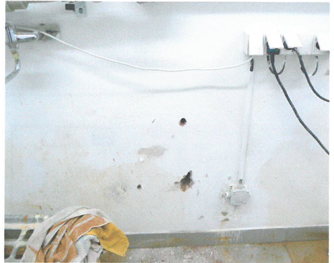
W - II m.č. 006 severní stěna
